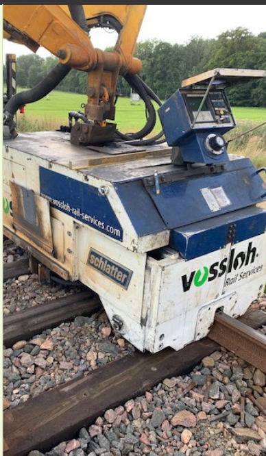
■ Brännsvetsning mellan Öxnared och Håkantorp. En teknik som är unik för STG.
