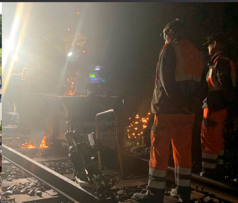
■ Brännsvetsning mellan Öxnared och Håkantorp. En teknik som är unik för STG.
