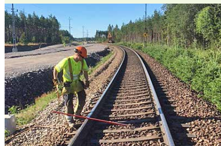
■ Arbete vid Stenकुmla.
