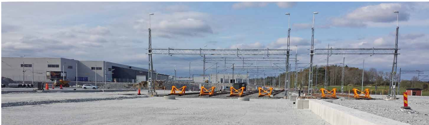
■ Den stora omlastnings- och kombiterminalen. Utmed yttersidorna syns de två kantbalakarna av betong för kanälerna för kranbanan och mitt emellan dessa skall de fyra järnvägsspåren byggas.
